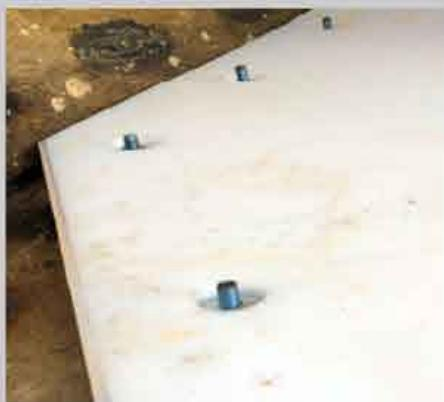
Насаживаем пластину на шпильки, приваренные по отмеченному точкам; надеваем прижимную гайку на шпильку и загоняем внутрь потая; наживляем и затягиваем низкую гайку M12; после затяжки гайки шпилька обрезаем по гайке с минимальным выступом, чтобы поместилась заглушка сверху
