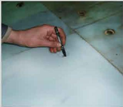
После просверливания отверстий прикладываем пластину к футеруемой поверхности и через отверстия маркером отмечаем места приварки шпилек шаг крепления составляет примерно 25-30 см и выбирается в зависимости от следующих условий: кривизны поверхности: пластина должна максимально плотно прилегать к футеруемой поверхности; сдвиговая/отрывная нагрузки на пластины; при монтаже листов размером более 2000x1000 мм крепления располагаются не только по периметру, но и в глубине пластины
