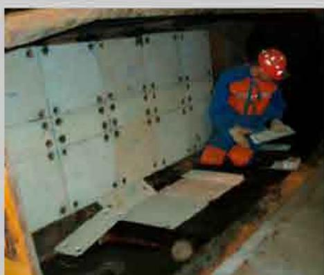
*Раскраиваем пластину и по периметру пластины сверлим отверстия под потай с шагом 25-30 см сначала сверлим первым сверлом несквозное отверстие под гайку или электропрокладку Ø40 мм; затем просверливаем сквозное отверстие в центре потай под диаметр штильки M12 с резьбой*
